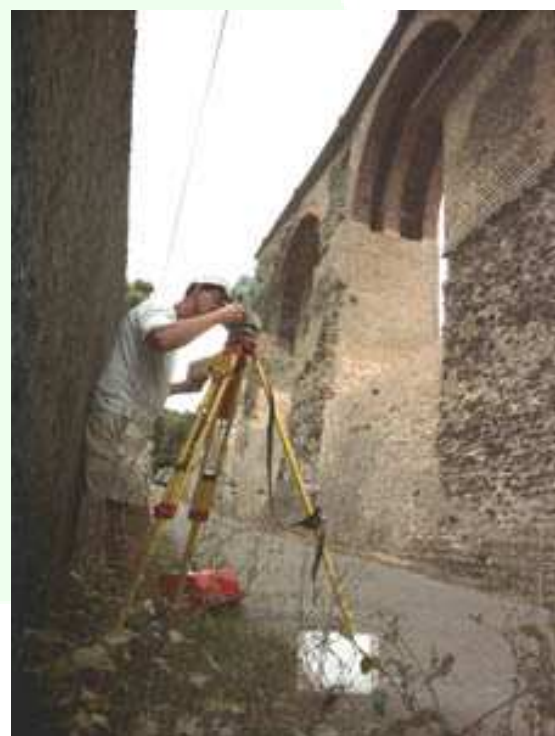
Travaux topographiques sur un aqueduc gallo-romain
